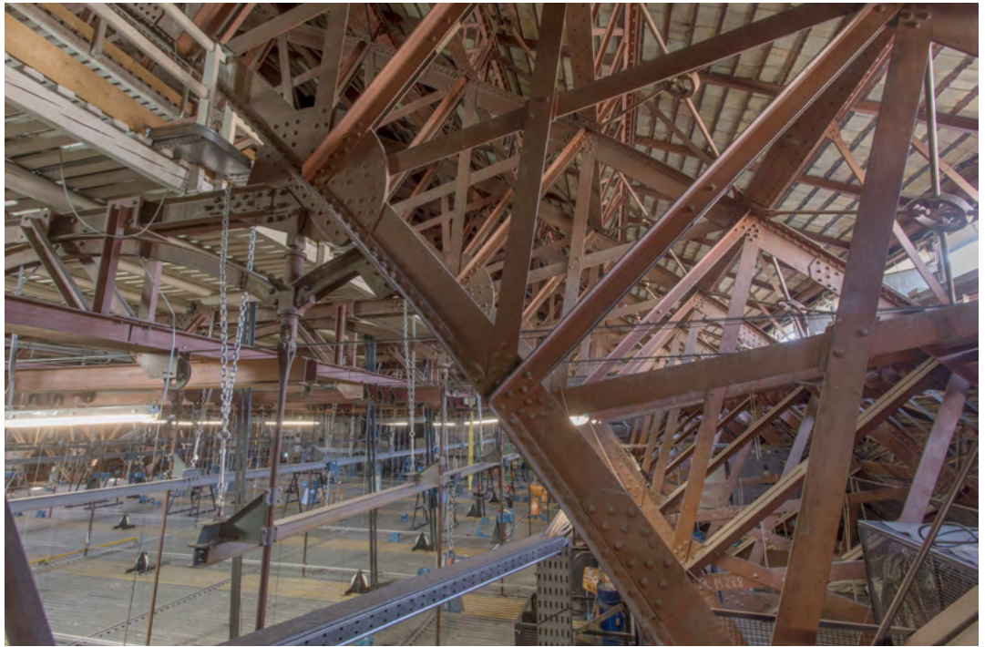
Schnürboden in Gusseisenkonstruktion
